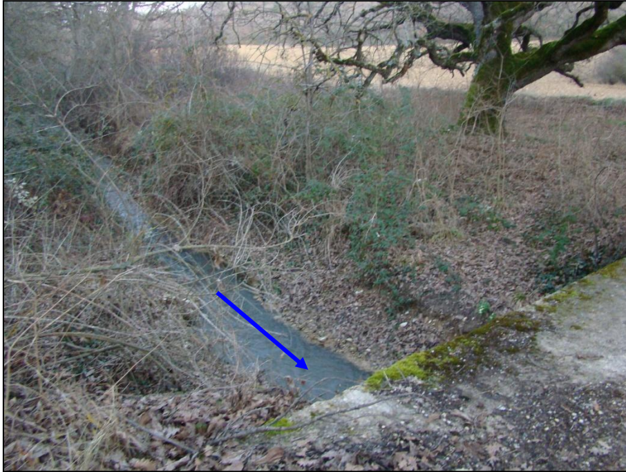
Figure 29 : L'Auvestre en amont de la limite communale Est [Source : IMS RN ]
