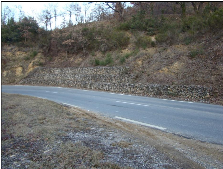
Figure 62 : Mur de soutènement en gabions le long de la RD 953, à proximité du ravin des Orgues [Source : IMS RN ]
