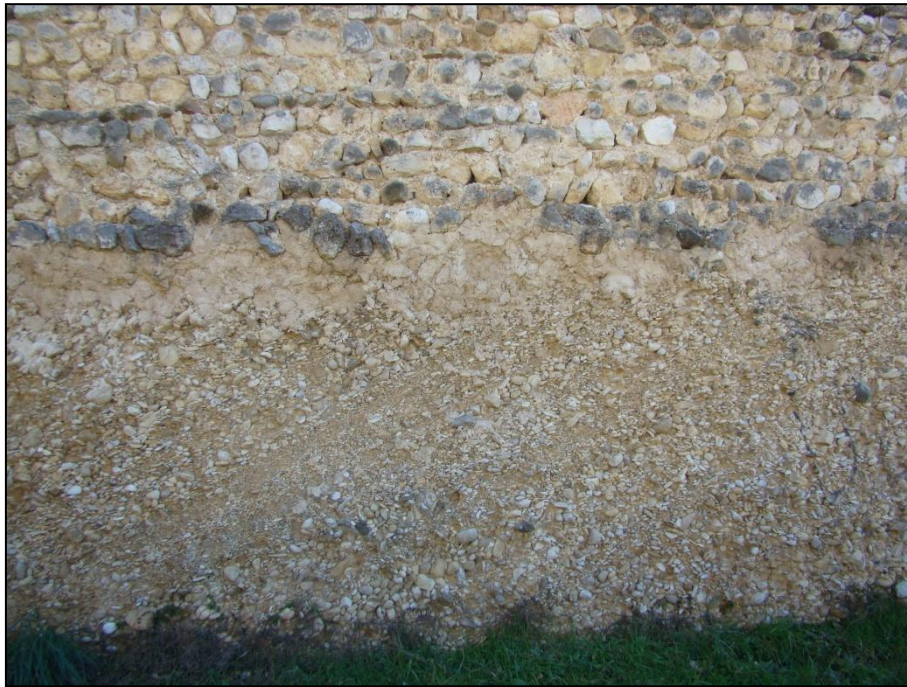
Figure 6 : Formation de Valensole sous les remparts du clocher de l'Horloge, dans le village de RIEZ [Source : IMS RN ]
