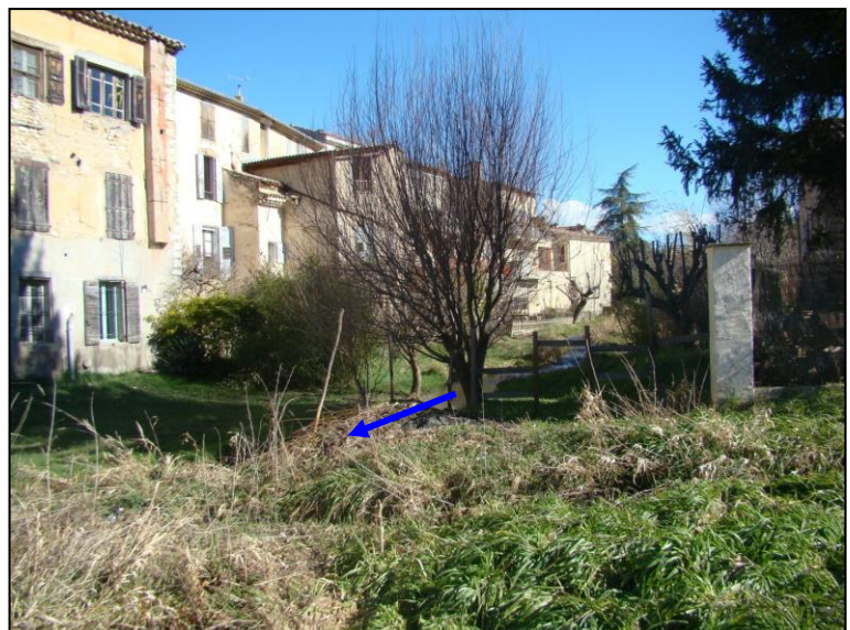
Figure 44 : Lit du Colostre encombré en aval du pont Jacquet [Source : IMS RN ]
