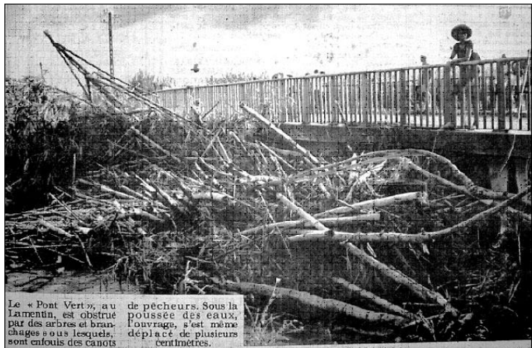
Figure 15 : Embâcle au niveau du Pont-Vert au Lamentin, Guadeloupe (en novembre 1966) [Source : France-Antilles]
