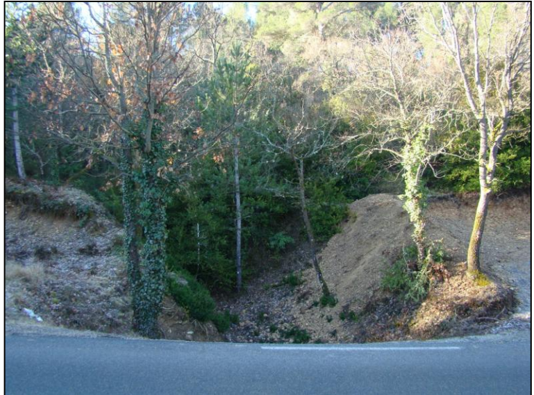
Figure 51 : Ravine en amont de la RD 11 dans le ravin de Valvachères [Source : IMS RN ]
