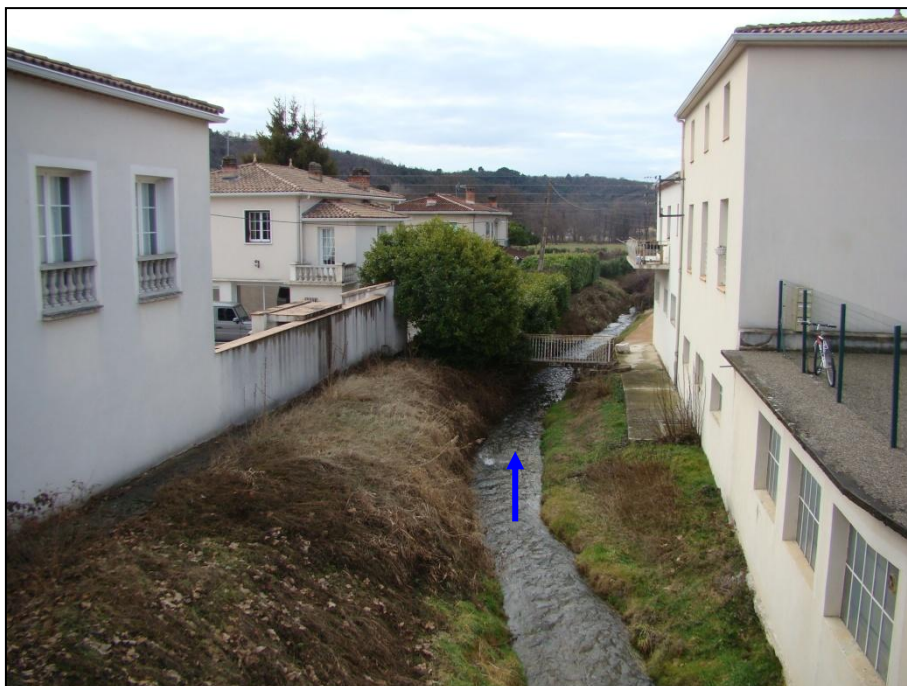
Figure 48 : Construction en bordure immédiate de l'Auvestre en aval de la RD 953 [Source : IMS RN ]
