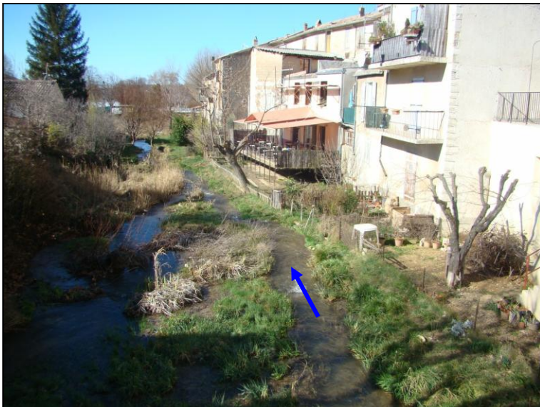
Figure 43 : Constructions dans le lit du Colostre en aval du pont Jacquet [Source : IMS RN ]
